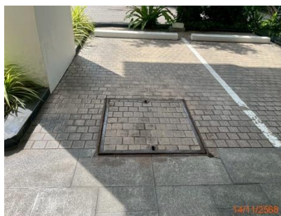
บ่อพักน้ำก่อนระบายออกสาธารณะ
