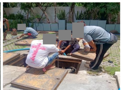
สูบล้างจากระบบบำบัดน้ำเสีย
